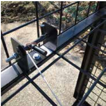
扉仕掛け(内側から撮影)
