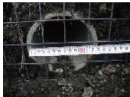
▼排水溝・排水管
